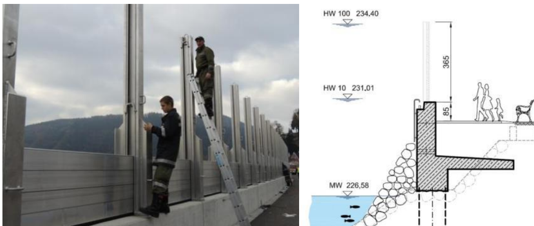
Рисунок 3.12. Сборка мобильной дамбы работниками дорожной службы (слева) [101], схема установки мобильной дамбы (справа) [102].
